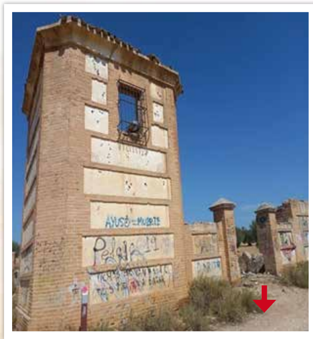
▲ Exterior: torre-capilla, ángulos achaflanados.
