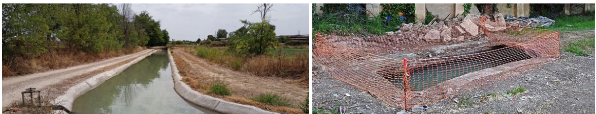
Ilustración 109. Caz de las Aves. Izq.: A cielo abierto. (F.a.) Der.: Tramo urbano abierto para reparación. (F.a.)
