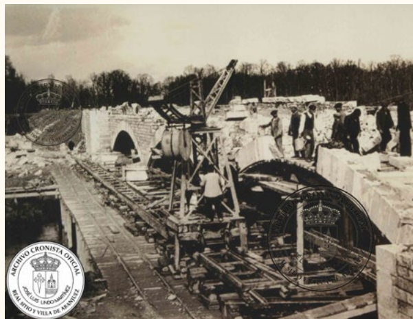
▲ Construcción del puente y vía sobre el río Tajo, a la entrada de la Est...aril.
